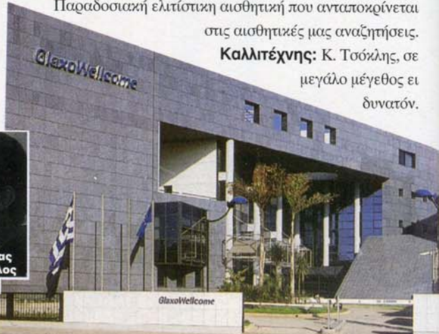
Το κτίριο της GlaxoWellcome στην Κηφισίας ξεχωρίζει από τα γειτονικά.
